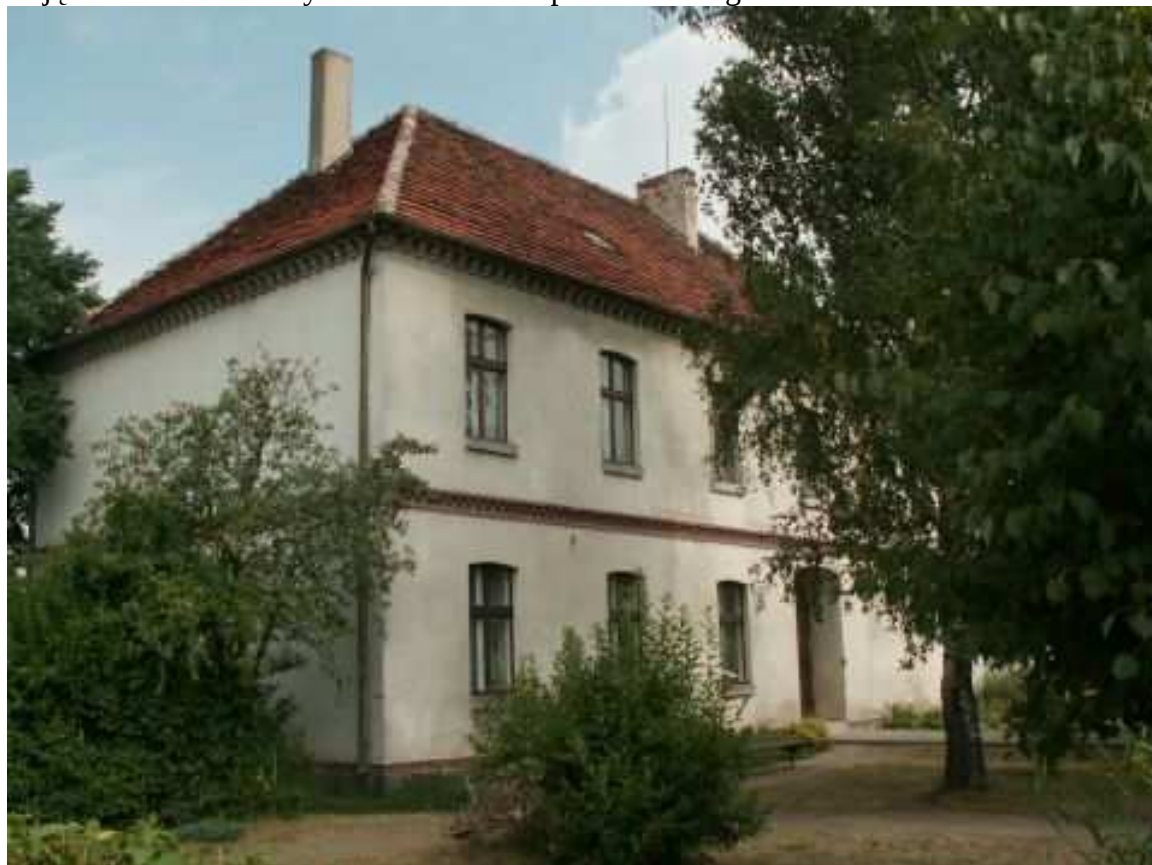
Zdjęcie Nr 1 Front budynku w Karczewie przeznaczonego do remontu
