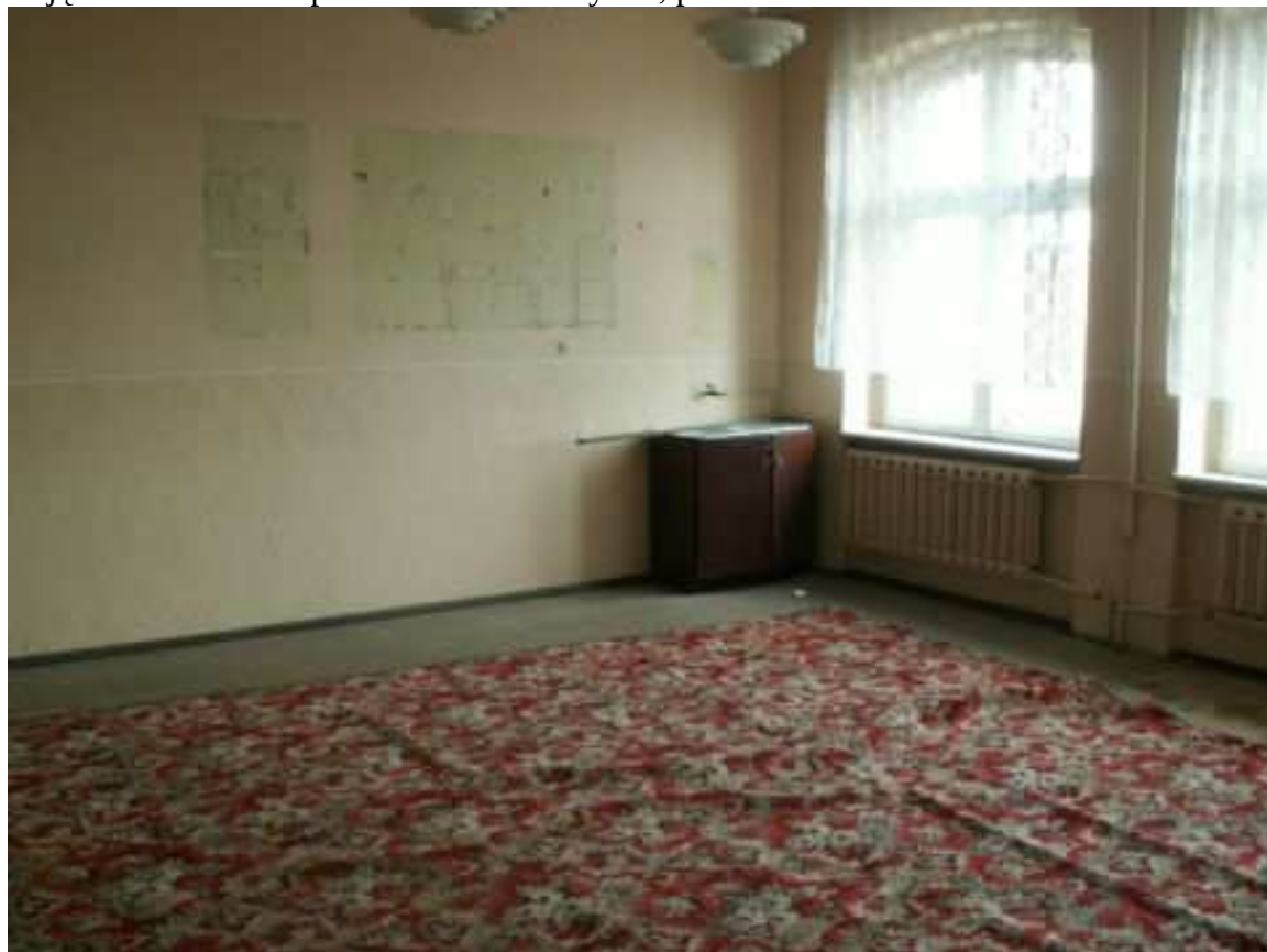
Zdjęcie Nr 3 Jedno z pomieszczeń w budynku, przeznaczone do remontu
