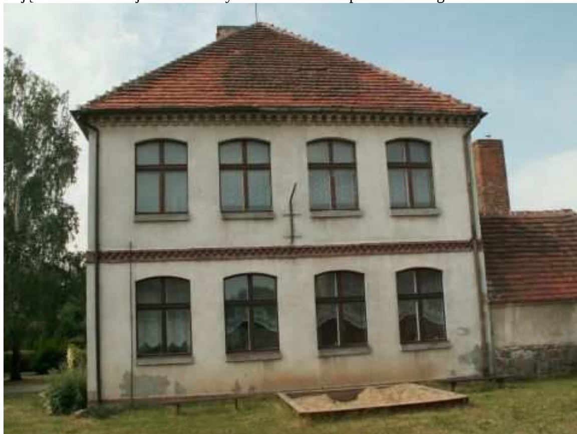
Zdjęcie Nr 2 Elewacja boczna budynku w Karczewie przeznaczonego do remontu
